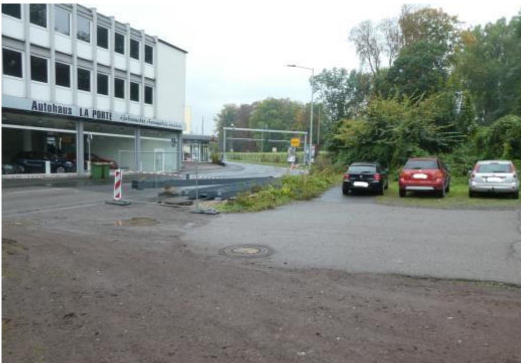
Abbildung 6: Parkplatz im Bereich des zukünftigen Wendehammers (Blickrichtung nach Süden).
