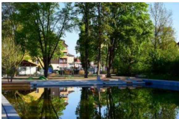
Abbildung 12: Wasserrückhaltesystem in Korbach (Quelle: Zentrum KlimaAnpassung, https://zentrum-klimaanpassung.de/ , Berlin 2023)
