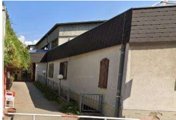
Abbildung 71: Fassade am Kinderhaus (Quelle: Google Maps)
